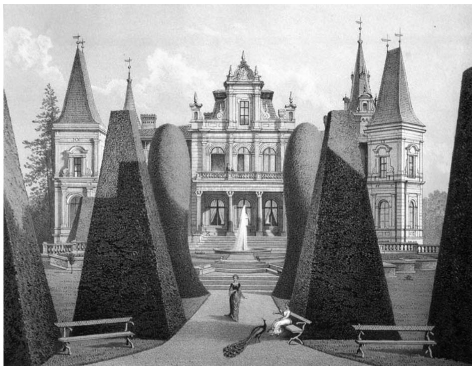
Pałac w Posadowie od strony ogrodu francuskiego. Litografia ze zbiorów Biblioteki Uniwersyteckiej w Poznaniu
